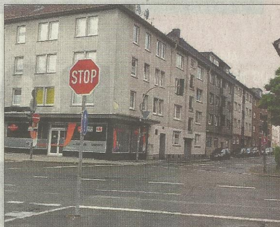
Hier im Bereich Bruchstraße, Klötttschen und Eppinghofer Straße soll Eppinghofens zweiter Kreisverkehr entstehen. Fotos (2): Emons
